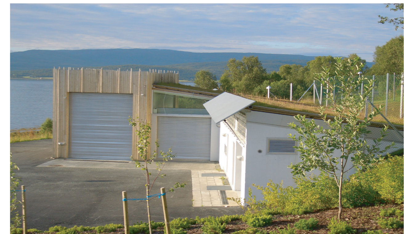
Figur 6: Renseanlegget ved Hamna på Tromsøya.
